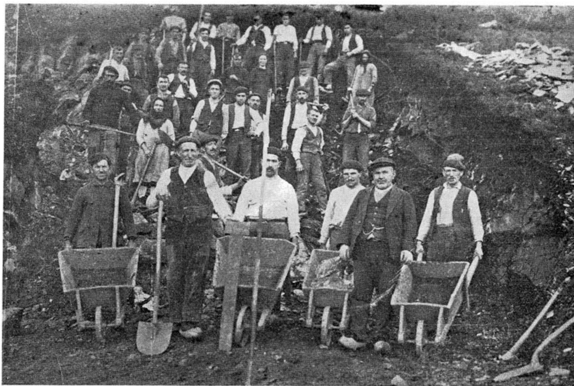
Los vecinos de Lavio, con el capataz (X) Dn. Joaquín Fernández al frente, trabajando en las obras de la carretera de Castañedo a Lavio, en el lugar conocido por la "Vuelta de la Esquita".
