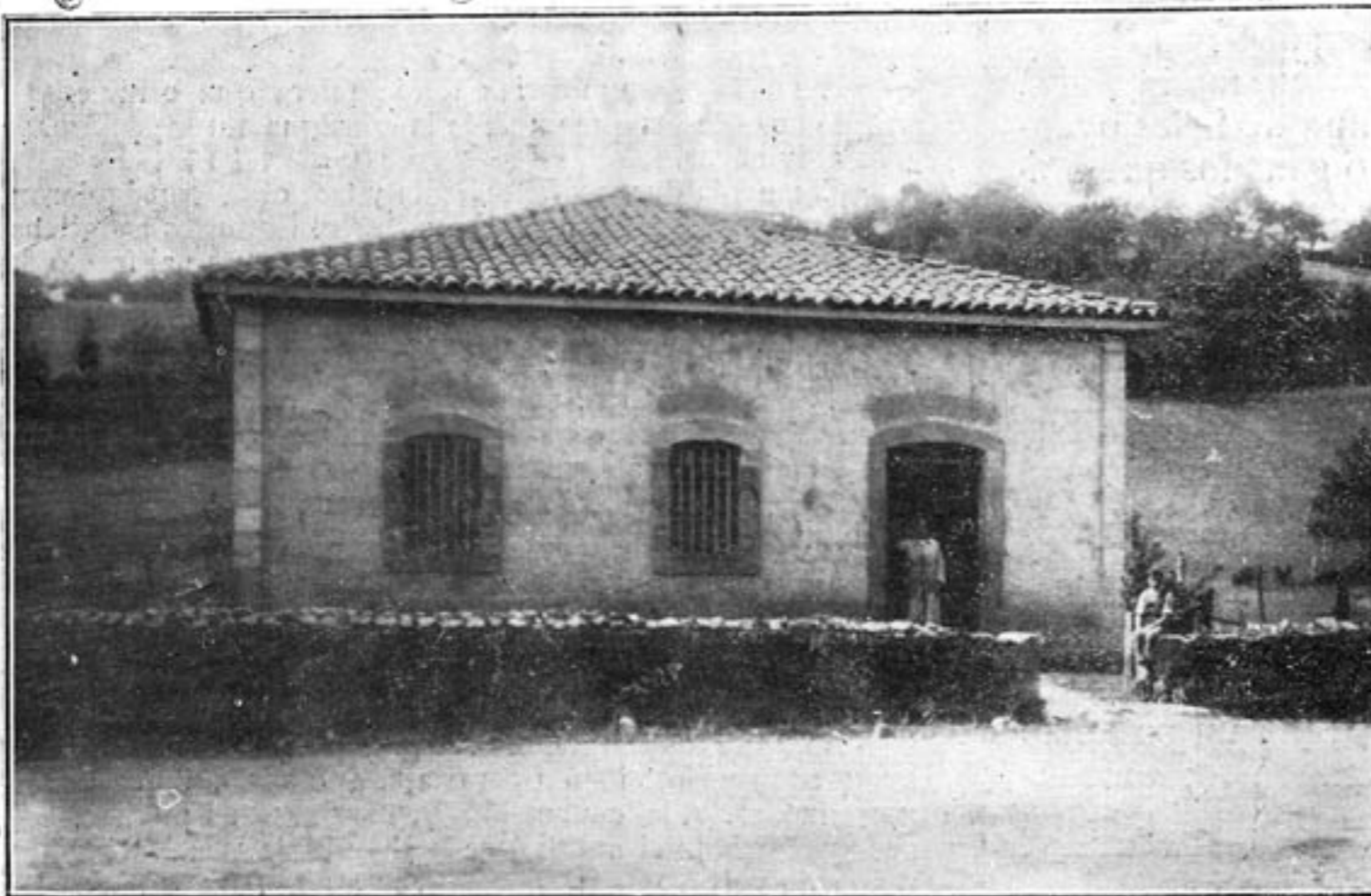
Almacén de la Cooperativa de Sebares.
