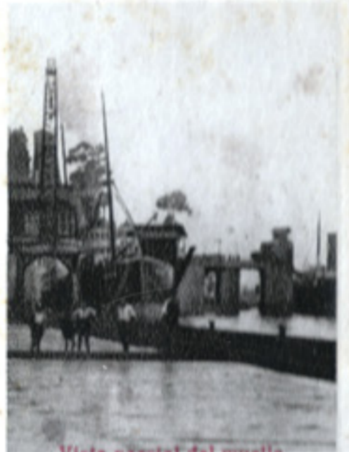
Vista paretal del muelle
