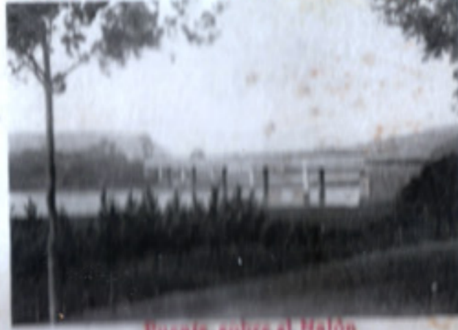
Puente sobre el Halón
