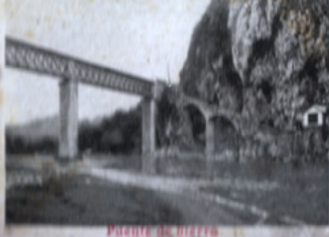
Puente de hierro
